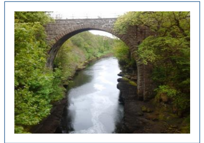
スコットランド・ブローラの鉄道橋
